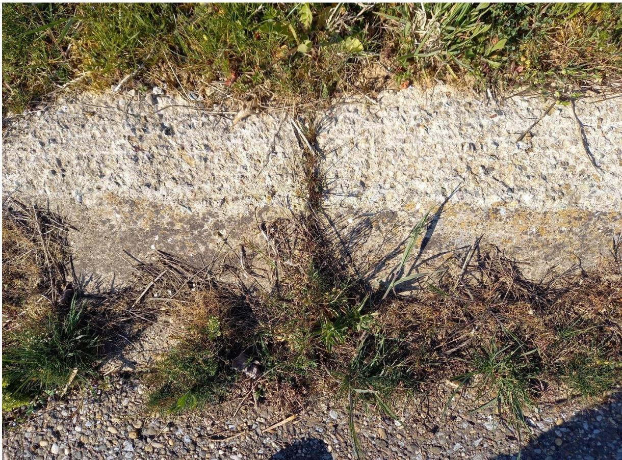
Im nachstehenden Bild ist abgebildet, wie der Übergangsbereich zu den nicht abgefrästen Steinen gestaltet wurde. Dies soll so auch in der Flurneuerung am Michaelsberg umgesetzt werden, da nicht auf der gesamten Länge Einfahrten in die Terrassen liegen. Im Bereich des Wassereinflaßes am unteren Ende der Treppe werden die Randsteine nicht bearbeitet.
